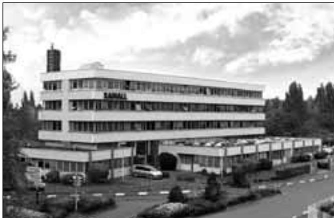
Head Office - Rosny sous Bois
